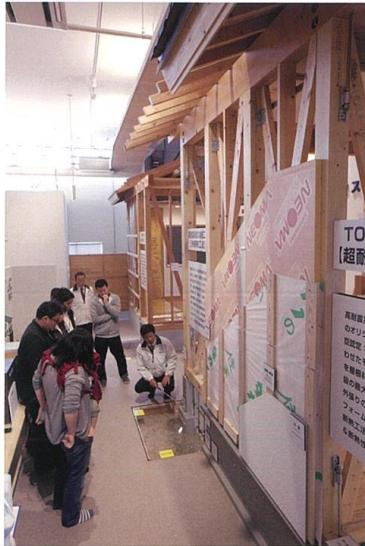
昭和55年頃の家とタカノホームの家を併設して再現。構造と断熱性能の違いをご紹介します。普段は見えにくい基礎内部も見ることができます。
